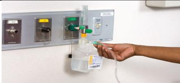
با باز کردن شیر اکسیژن، لوله و مسیر عبور اکسیژن را از نظر انسداد بررسی کنید.
