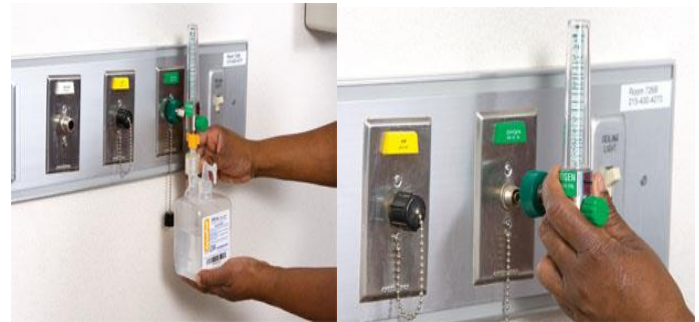
سیلندر اکسیژن و مانومتر را چک و بررسی کنید (از نظر پر بودن کپسول و عدم نشتی و وجود آب مقطر در سیستم مرطوب کننده)
